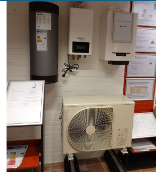
Opstelling splitunit warmtepomp + buffervat / binnendeel warmtepomp / cv-ketel
